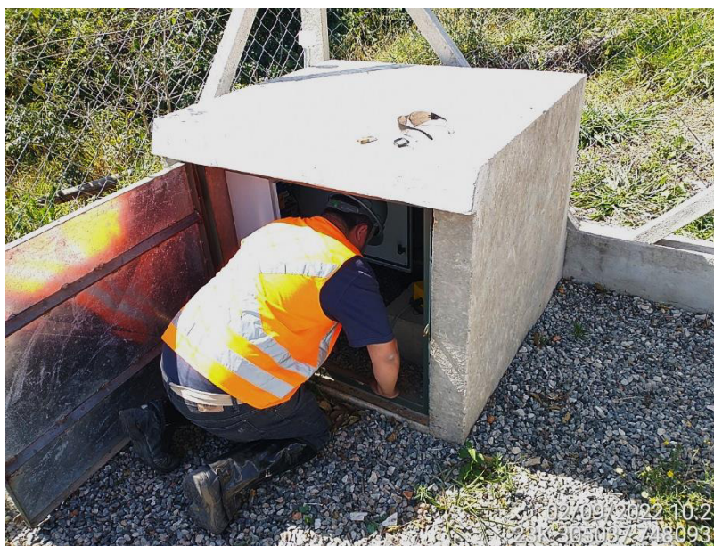
Foto 1 – Atividade de manutenção nos equipamentos. (Data: 02/09/2022).
